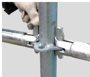
②クサビを引き上げ、フランジ孔に差し込みハンマーで打ち込み確実に固定させます。
